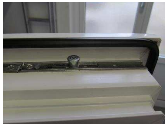
Bild 14 Verriegelungssituation Flügelrahmen 2
