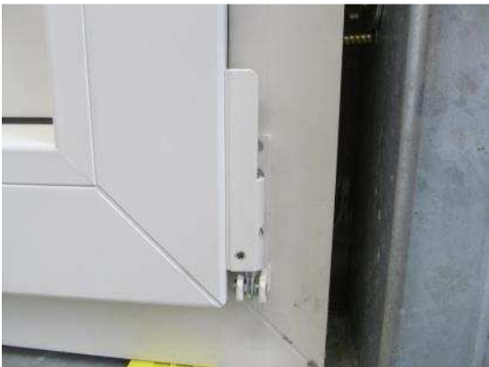
Bild 8 Ecklager, Innenansicht
