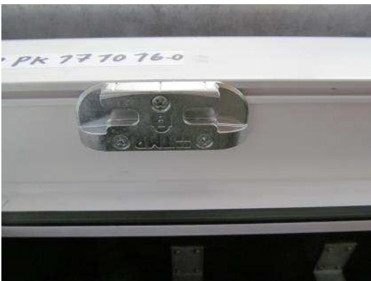
Bild 13 Verriegelungssituation Blendrahmen 2
