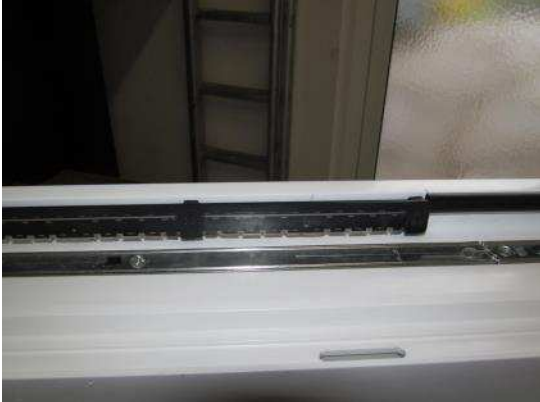
Bild 17 Falzlüfter in eingebautem Zustand
