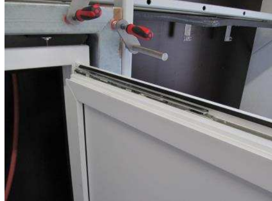
Bild 7 Scherenlager, Falzansicht
