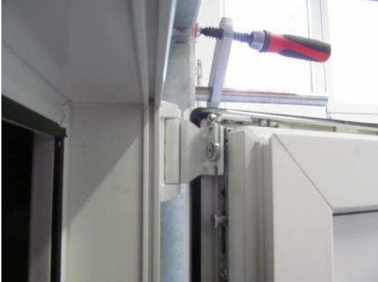
Bild 6 Scherenlager, Innenansicht
