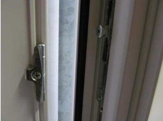
Bild 12 Verriegelungssituation Blend- Flügelrahmen 1
