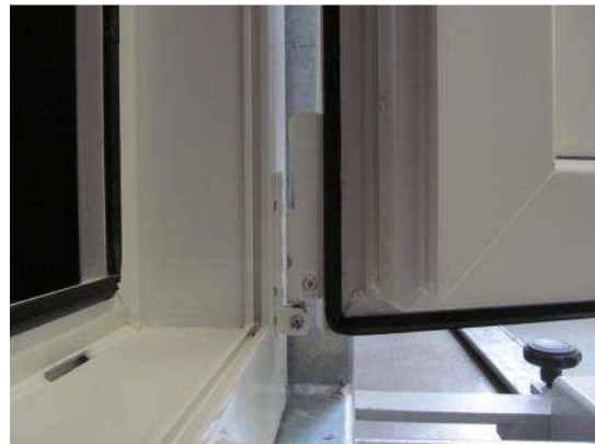
Bild 9 Ecklager, Falzansicht
