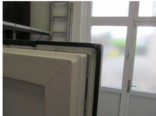
Bild 3 Flügelrahmen, Eckausbildung
